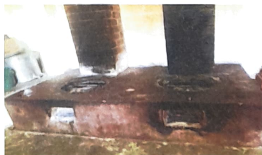
Foto 6: Reparación de cocina
