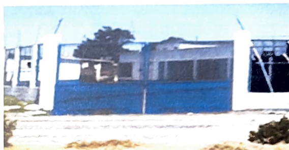
Foto 2: Puertas de metal
